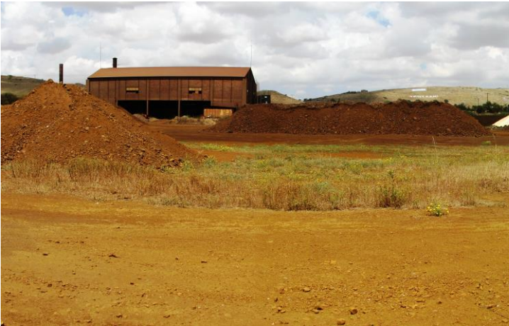
Εργοστάσιο επεξεργασίας φαιοχωμάτων και οι σωροί διαφορετικών αποχρώσεων.
